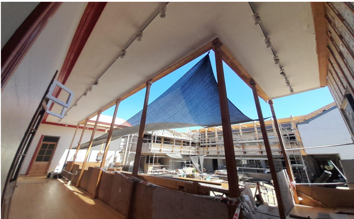
Restauración del Museo Municipal de Mejillones.
