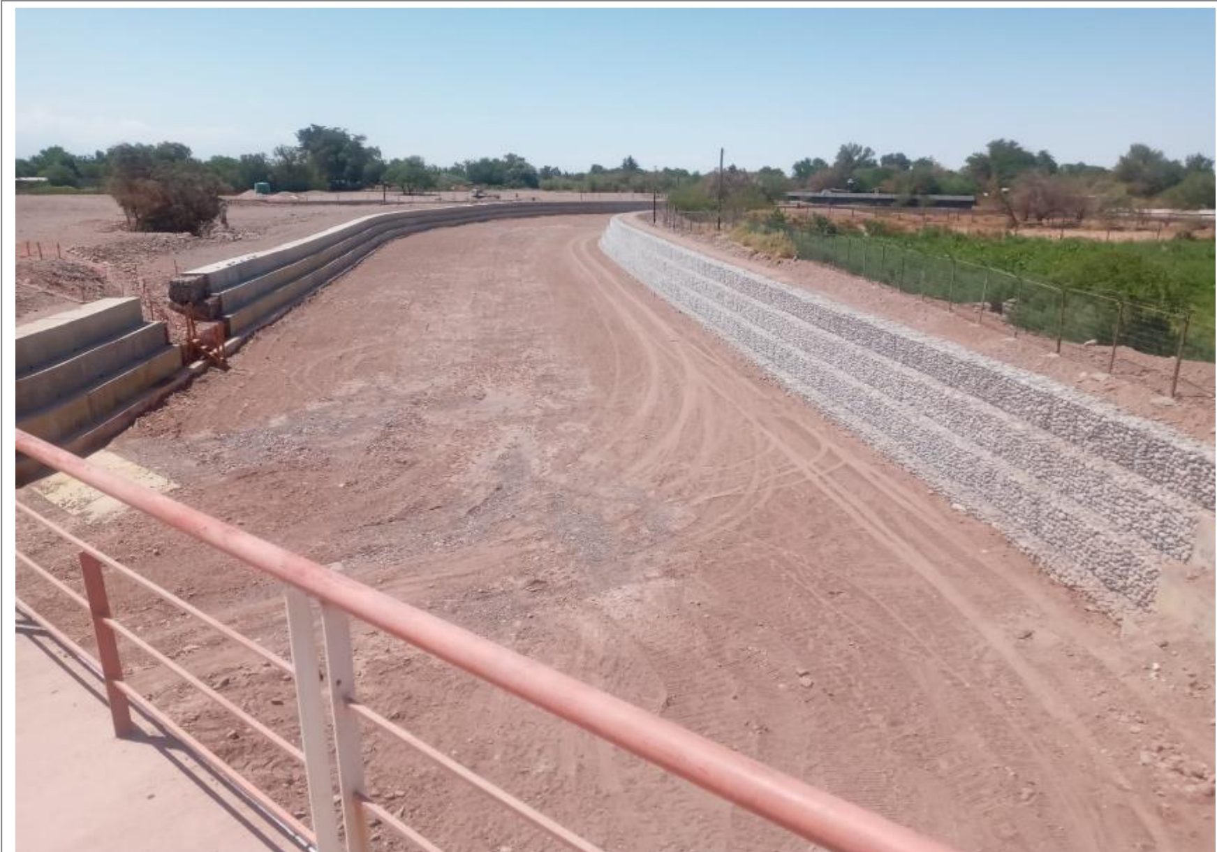
Mejoramiento Ruta B-241, Eje Licancabur, Pasada Urbana San Pedro de Atacama, Región de Antofagasta. Etapa I, obras fluviales Puente río San Pedro.
