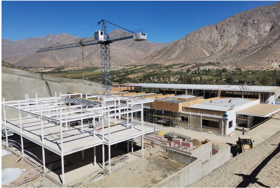
Obras del nuevo Centro de Salud en la localidad rural de Carén en Monte Patria, las cuales concluyen este 2023
