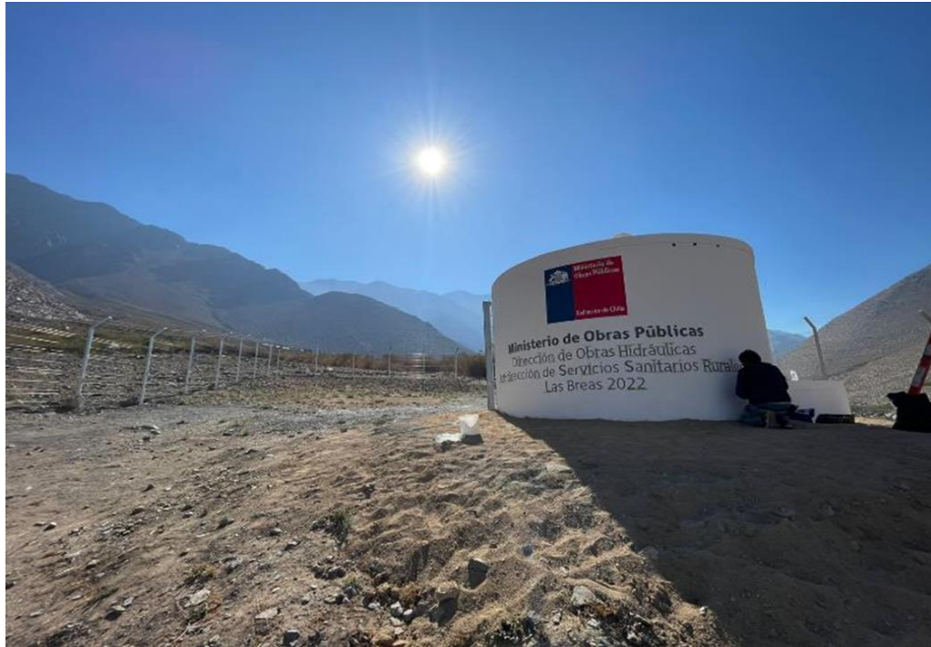
Nuevo Estanque para sistema de agua potable rural de Las Breas en Río Hurtado
