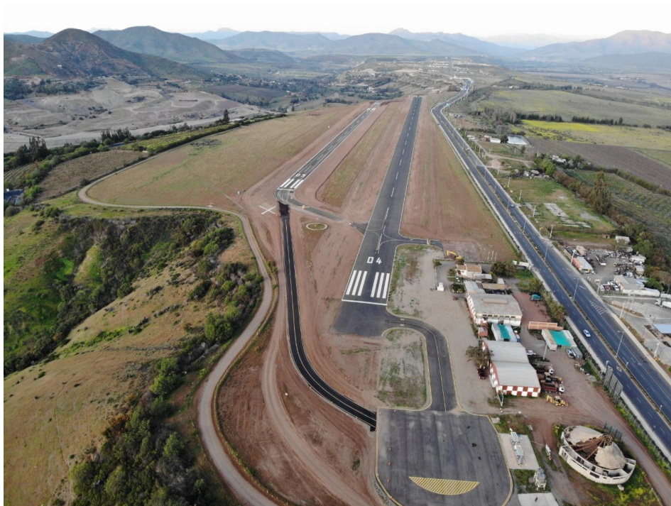
Imagen aérea de las obras de conservación en “Aeródromo El Tuqui de Ovalle”.
