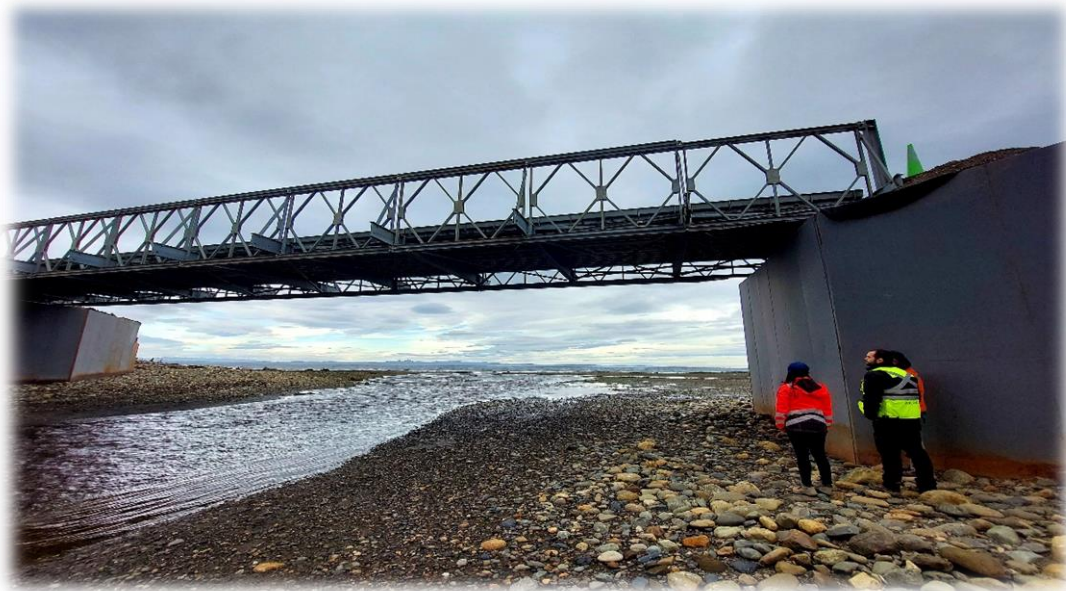
Habilitación Puente Río Caleta, Timaukel, Provincia Tierra del Fuego.
