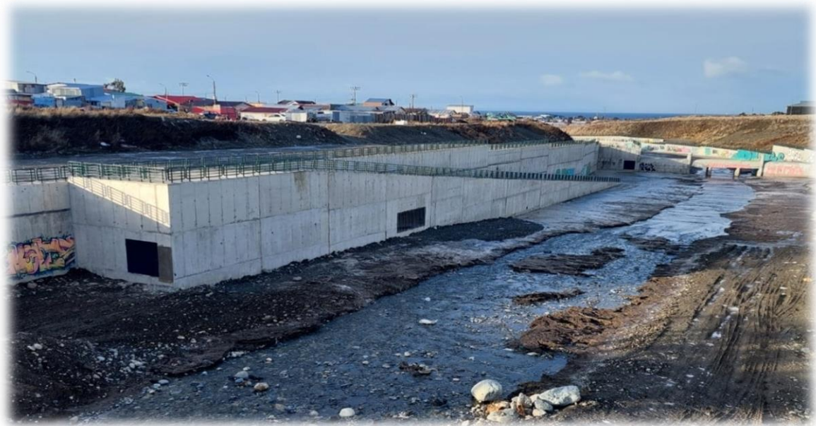
Construcción de obras de control sedimentológico Río de las Minas 3era etapa
