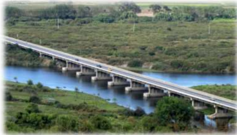
Actual Puente Lo Gallardo
