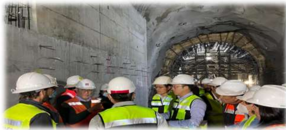
Túnel de desviación – Embalse Las Palmas
