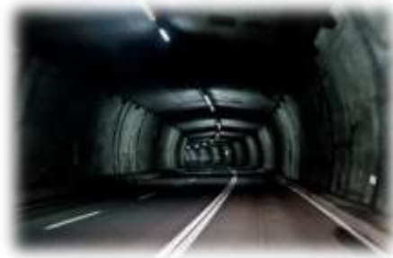
Proyecto Segundo Túnel La Grupa
