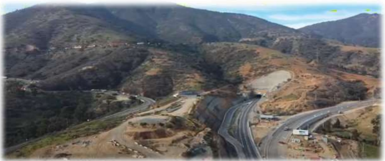
Segunda Concesión Túnel El Melón
