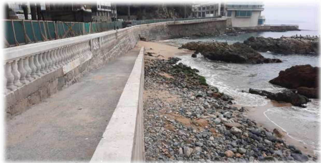
Obras Conservación Socavación Av. Marina – Viña del Mar.
