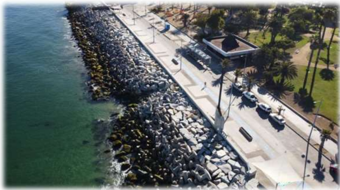
Obras de Conservación y protección Av. Perú – Viña del Mar.
