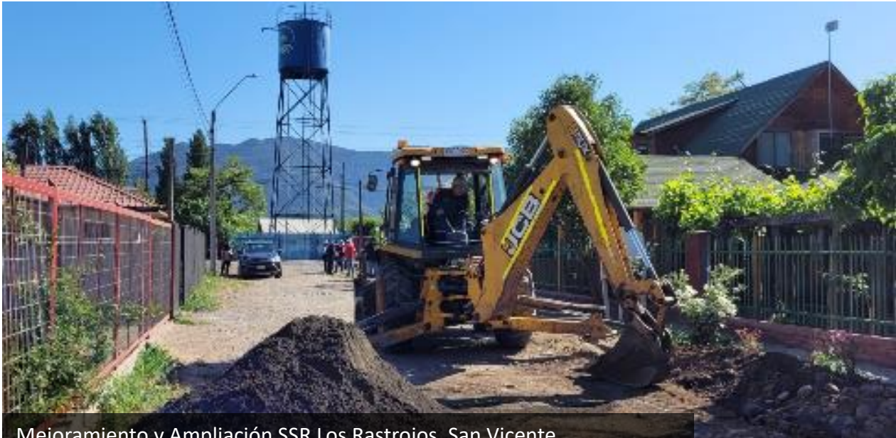
Mejoramiento y Ampliación SSR Los Rastrojos, San Vicente. MM$ 2.615
