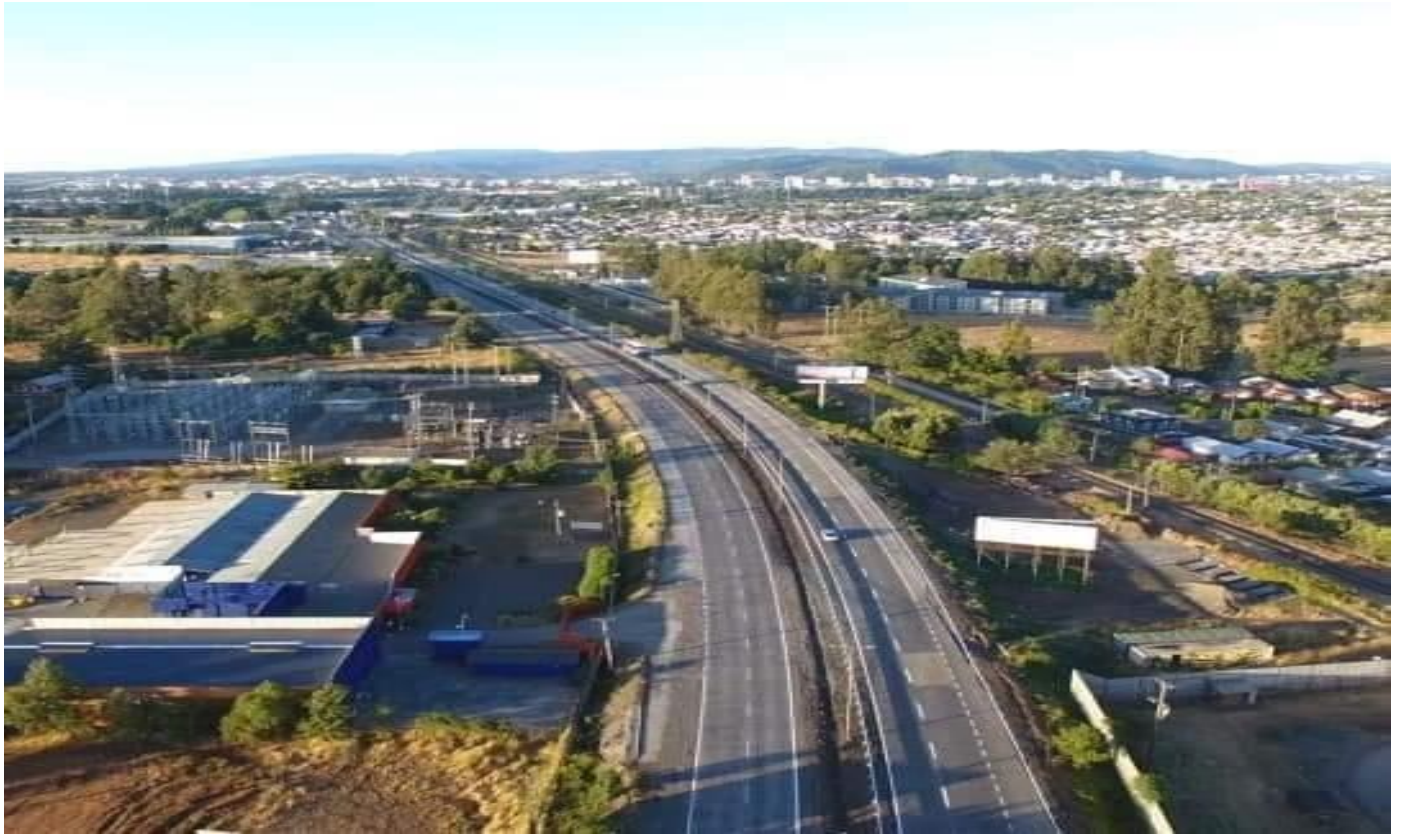
Obras de conservación sello y bacheo del acceso sur-norte
