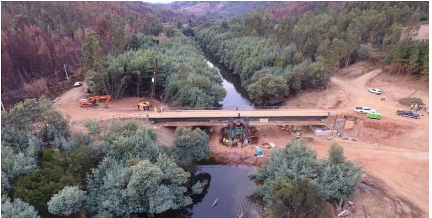
Reposición Puente Muco, en Lautaro y Reparación Puente Peyahuen
