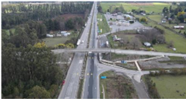
Imagen 3.4: Fotografía Aérea del Puente Peatonal sobre Ruta 5 Sur - Ctra. MON20
