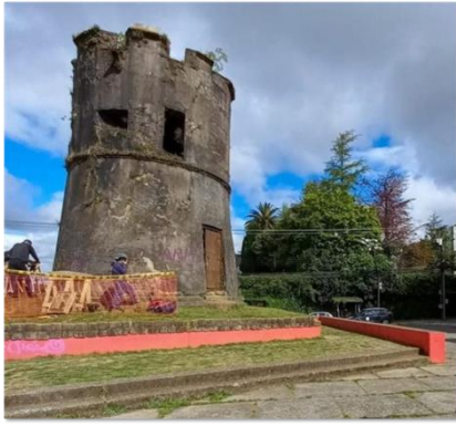
RESTAURACION Y PUESTA EN VALOR TORREONES DE FORTIFICACION VALDIVIA. M$ 198.465.-
