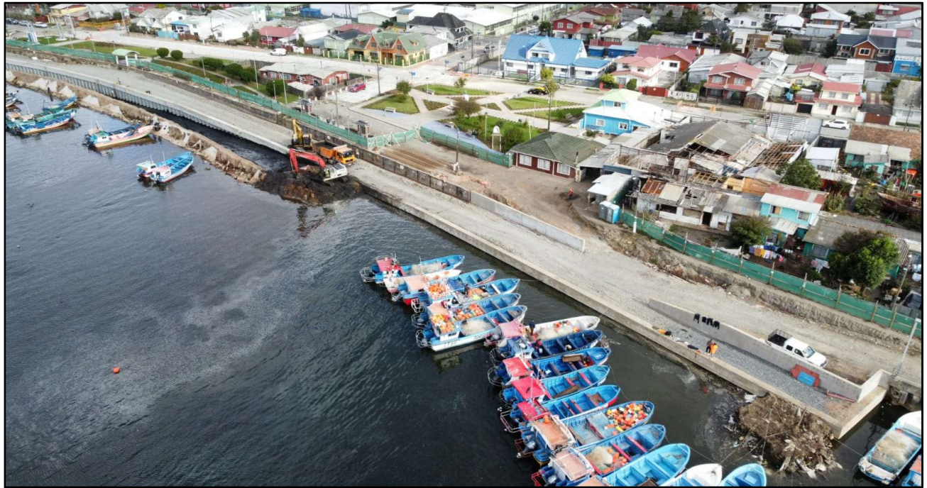
Embarcadero de Servicio Ribera Sur Rio Lebu en ejecución
