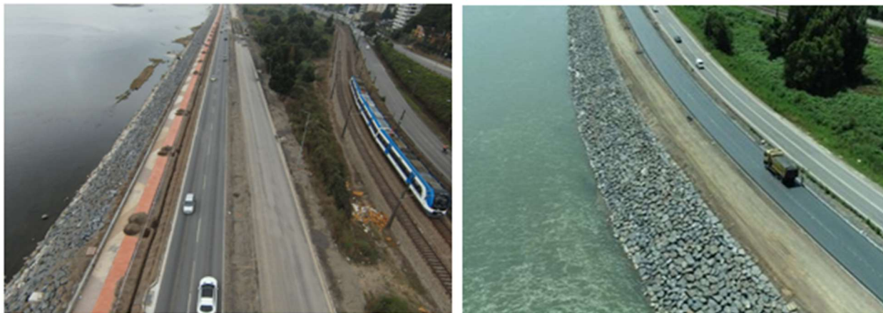
Costanera Concepción-Chiguayante en construcción
