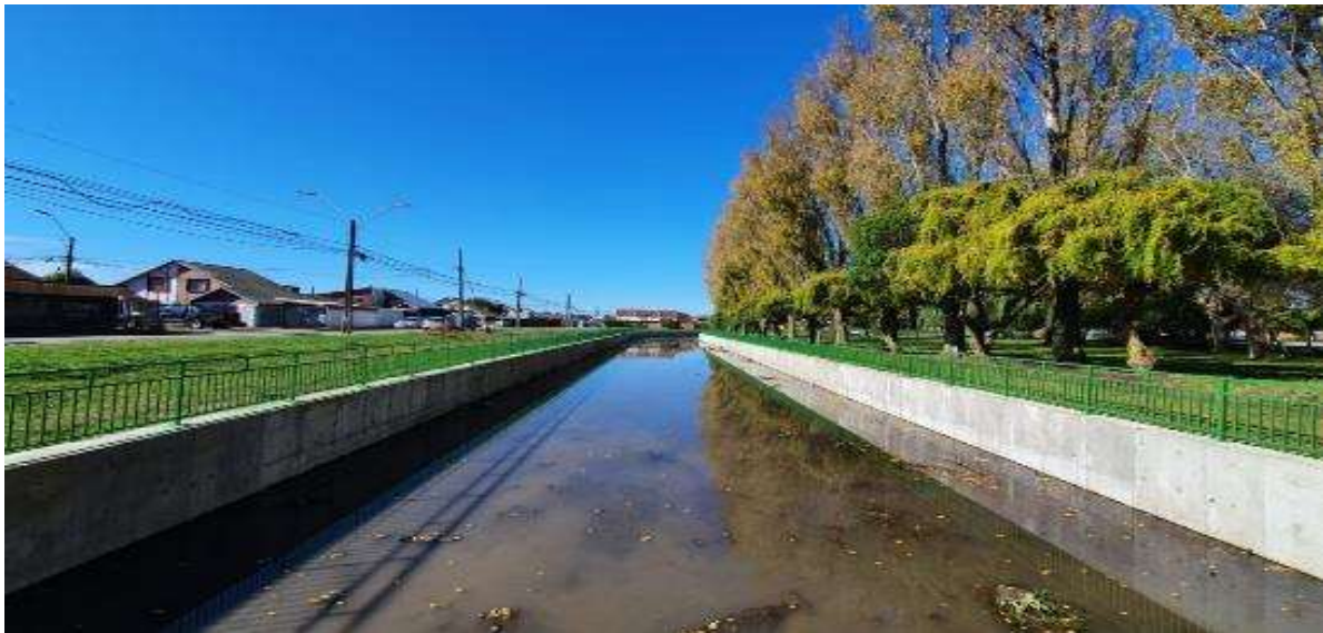
Obras de Aguas Lluvias Canal Denavisur, comuna de Talcahuano.
