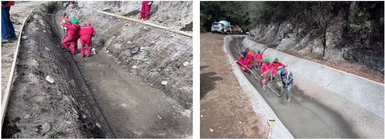
Obras de revestimiento Canal Cayucupil
