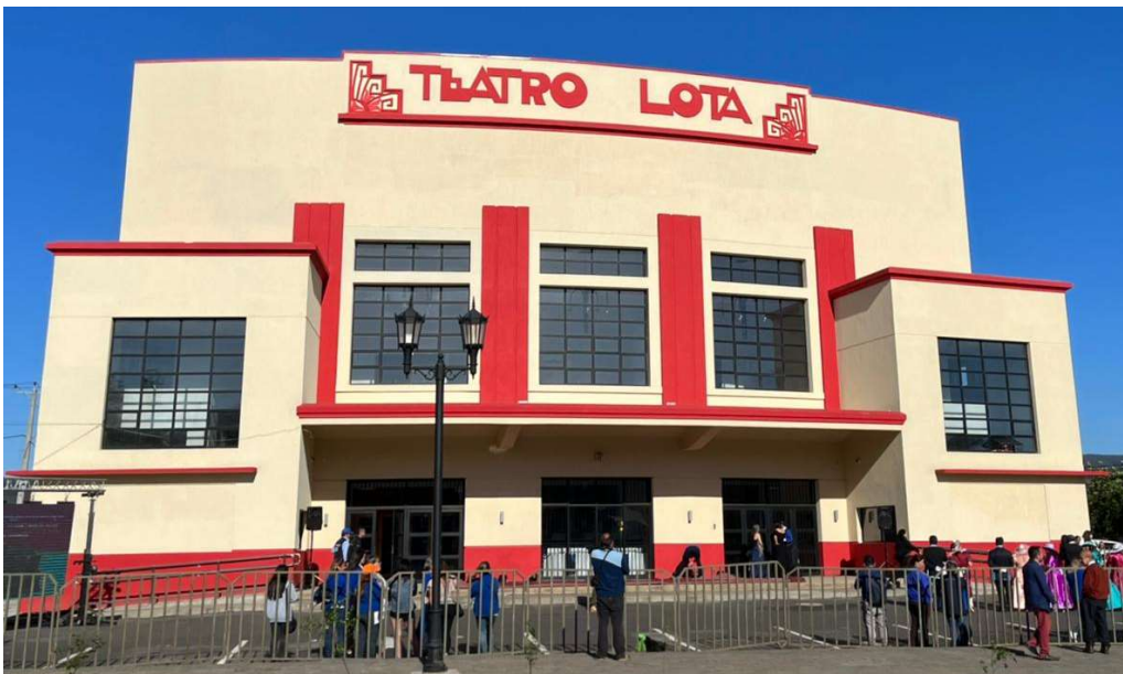
Restauración y Habilitación Ex teatro ENACAR Lota Alto (Después)
