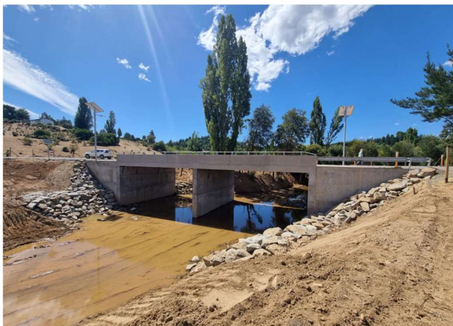
Reposición Puente Bilbao, comuna de Yumbel
