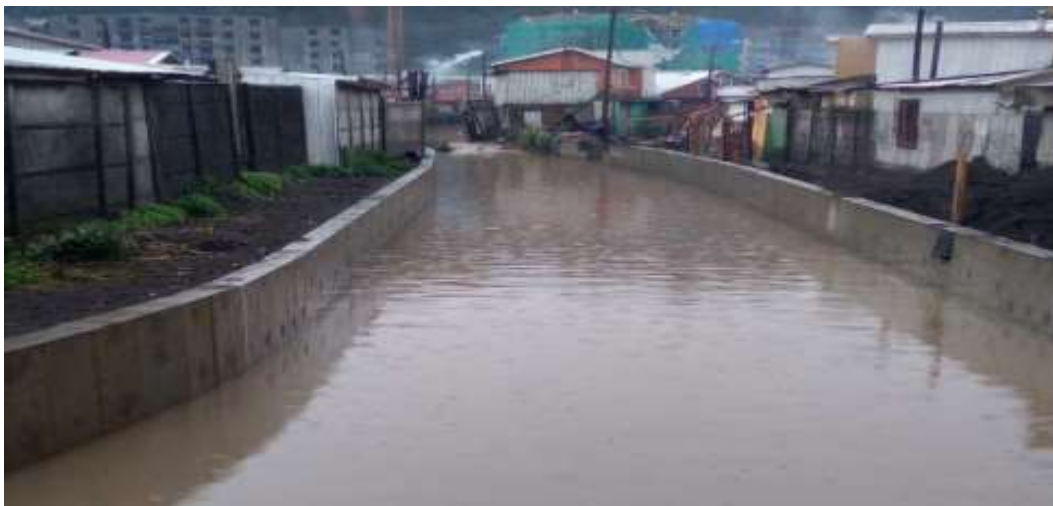
Construcción Colectores Sector La Playa, Lota
