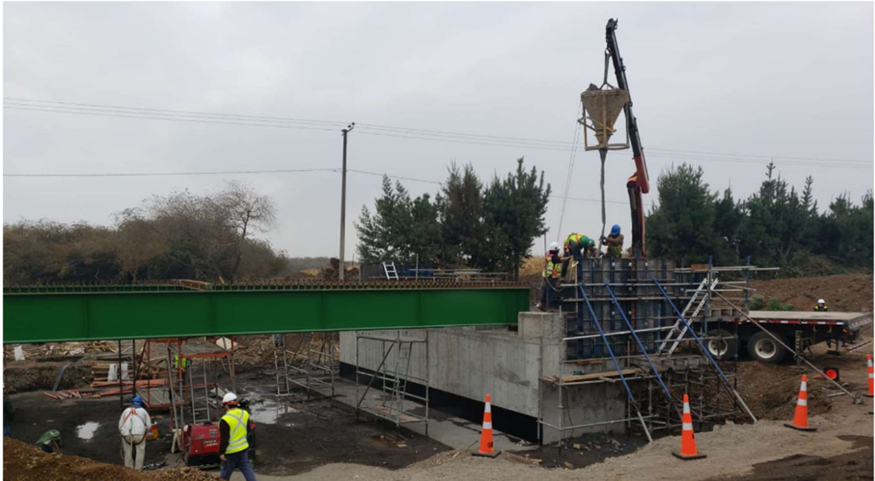
Ruta Q-80 y Puente Rapelco en construcción
