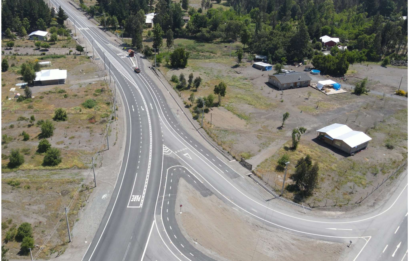
Pavimentación Ruta Q-30
