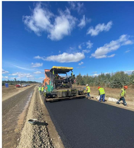
Ruta Q-80 y Puente Rapelco en construcción
