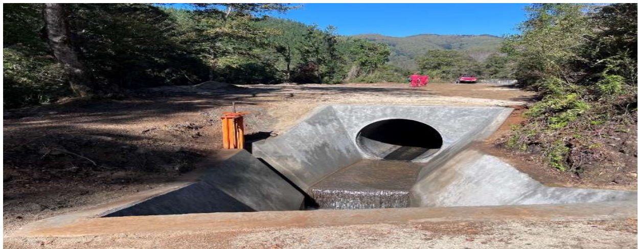
Suministro e instalación de tubería HDPE Canal Matriz Cayucupil
