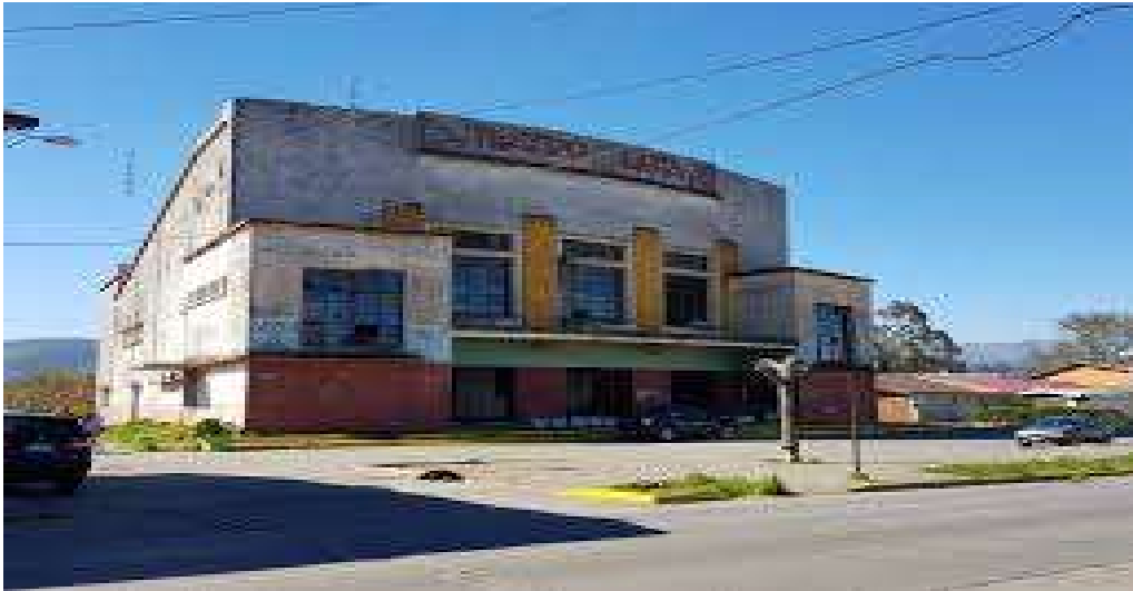
Restauración y Habilitación Ex teatro ENACAR Lota Alto (Antes)
