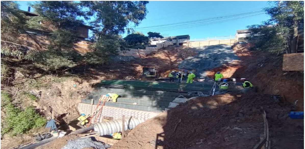
Reposición de obra de atraveso mediante Túnel Lainer
