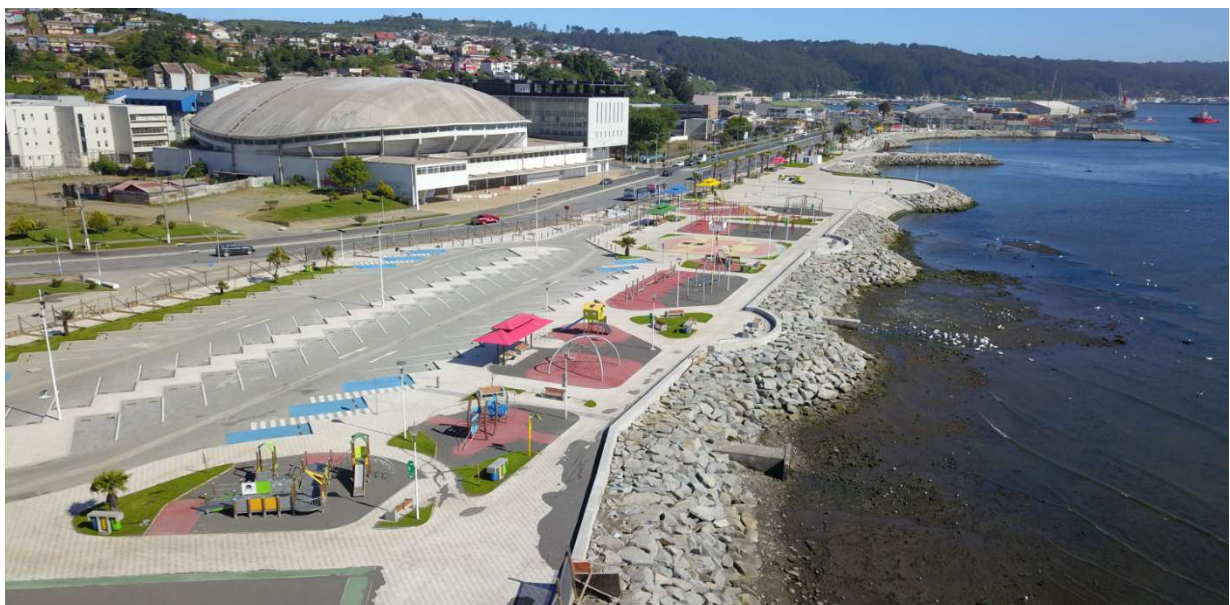
Obras en La Poza de Talcahuano
