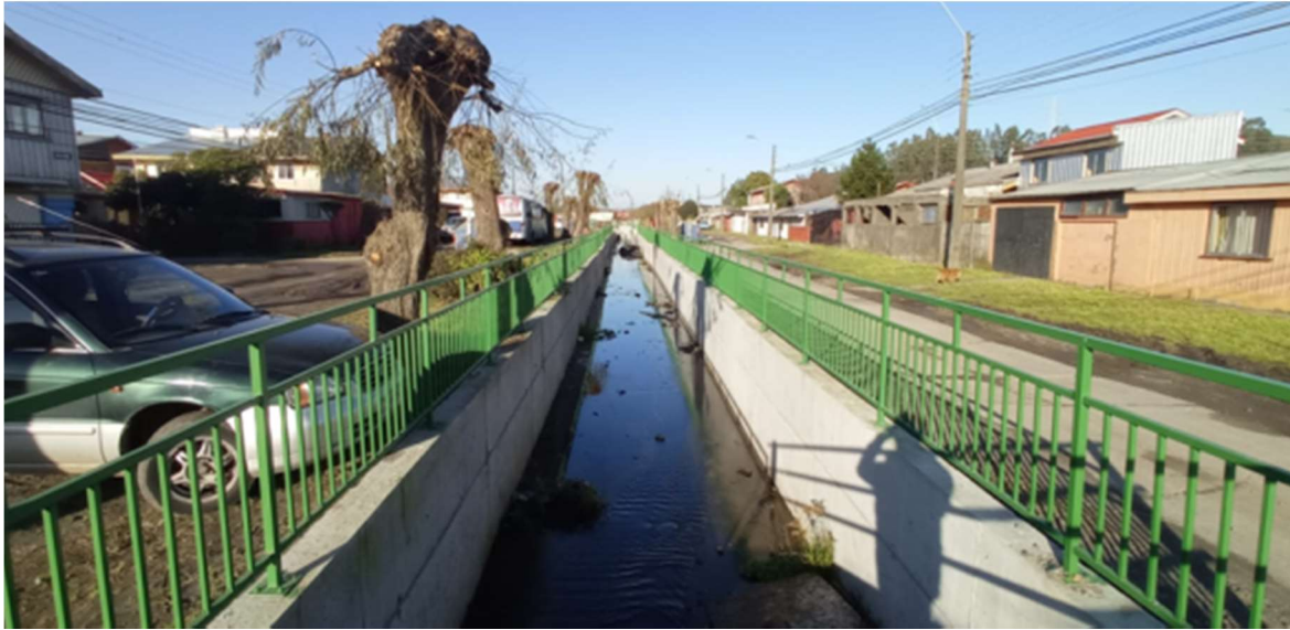
Obras de Aguas Lluvias Canal Retroque, comuna de Talcahuano.
