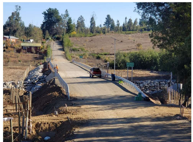
Reposición Puente San Bernardo 2, comuna de Florida
