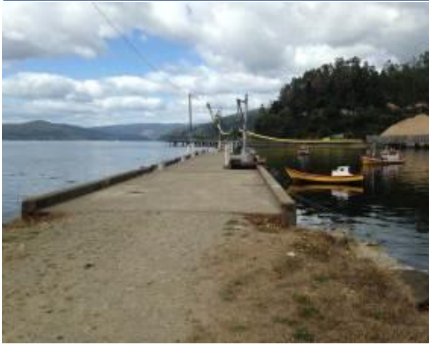
Rampas de Varado
