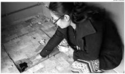
SUSANA SANCHEZ MUESTRA SU CÁMARA DE ALCANTARILLADO EN SU ALMACÉN DE COLAPAR
