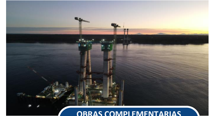
OBRAS COMPLEMENTARIAS PUENTE CHACAO
