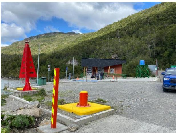
El proyecto consideró la conservación del refugio de pasajeros con su respectiva normalización a accesibilidad universal, al igual que el estacionamiento correspondiente. Para la rampa para barcas se realizó la mantención de las bitas de amarre y para la explanada se realizó conservación de la canaleta de evacuación de aguas lluvias, y la señalización vertical correspondiente. Consideró además la implementación de postes de alumbrado de alimentación
