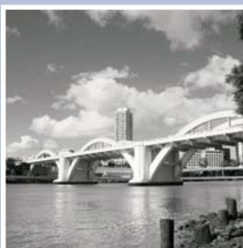
Arcos Hormigón tablero intermedio
