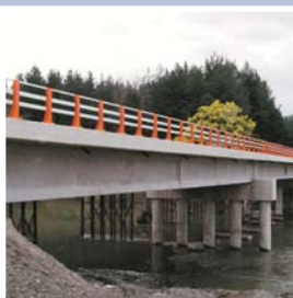
Puente postensado y tablero H.A
