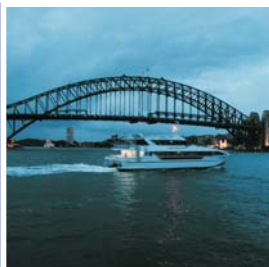
Arco metálico con tablero interior
