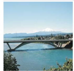
Puente con tornapuntas
