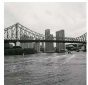
Arco enrejado de acero
