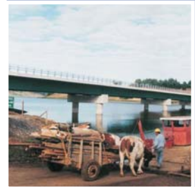
Vigas metálicas continuas
